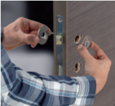
Placer les rosaces de béquilles en insérant les piliers traversants dans les perçages prévus d'usine.
