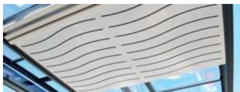
Ajouré avec découpe de 5 mm pour passage air/lumière
